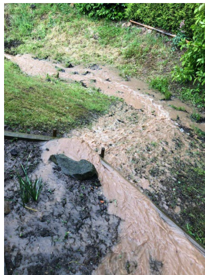
Abbildung 12: Auswirkungen Starkregenereignis nach Sommergewitter 2022, Am Bahndamm Miehlen (Quelle: VG Nastätten)
