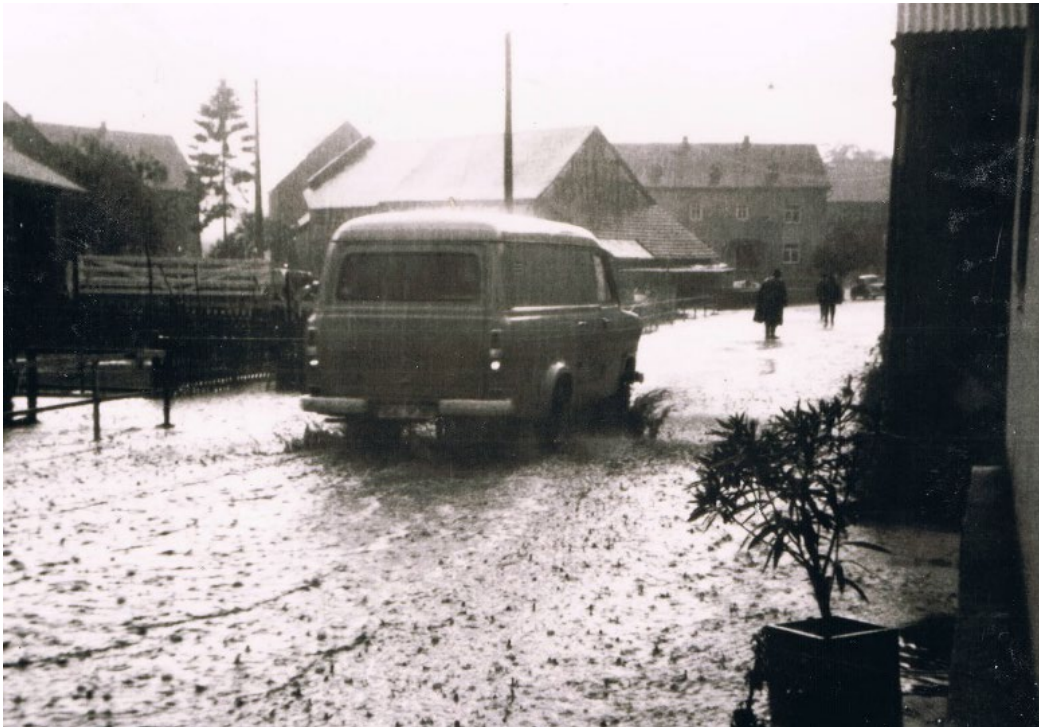
Abbildung 12: Hochwasserereignis Niederbachheim 1970 (Quelle: N. Heinz)
